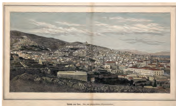
1587 CLOSS A. ANSIGHT VON SYRA. Nach einer photographischen Originalaufnahme. 1870-80. Επιχρωματισμένη λιθογραφία της Σύρου, κείμενο στην πίσω όψη. Σπάνια. Διαστάσεις 32 x 16,2 εκ. 50 - 60
